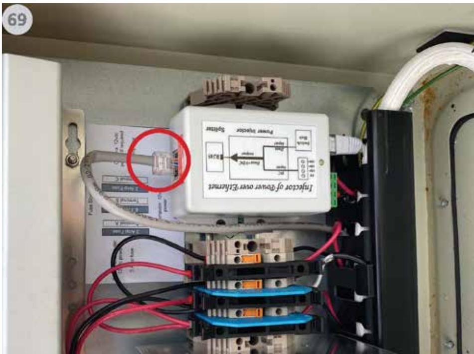
Cable de la central de conexión, cable DriveOver de 10m.
